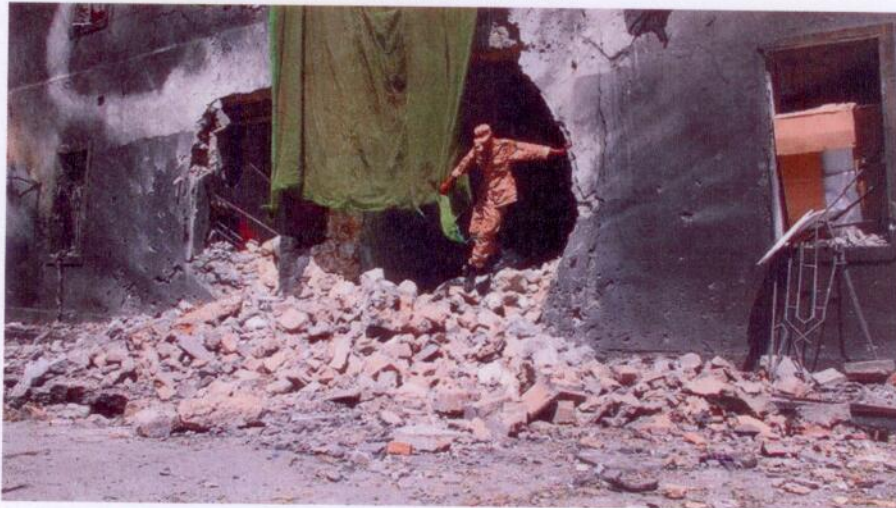
Ein Gebäude des Aussenministeriums in Benghazi wurde durch einen Anschlag in der vergangenen Woche stark beschädigt. (Bild: Keystone / EPA)
